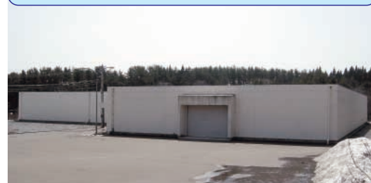
固体廃棄物貯蔵所の外観
