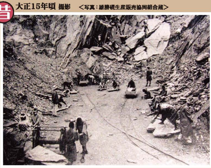
手作業による探掘で、運び出すトロッコも人力によるものだった。
