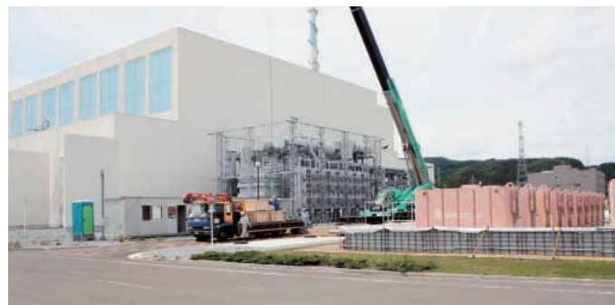
50万ボルトへの昇圧工事(主変圧器)
