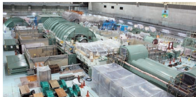
タービンなどを分解点検(タービン建屋)
