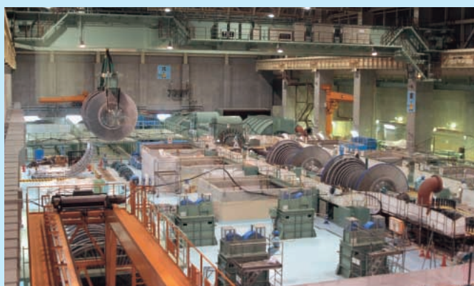
定期検査の様子(タービン建屋)
