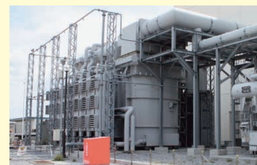
昇圧工事を行う主変圧器
