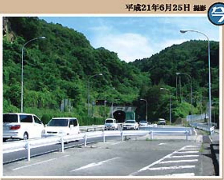
右の写真と同じポイントから撮影した今の牧山道路。無料化によって料金所はなくなったが、道幅とコンクリートの基礎にその名残が感じられる。
