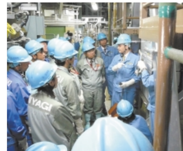
▲今回の定期検査で実施した耐震性を高める工事の施工状況をご確認いただきました
