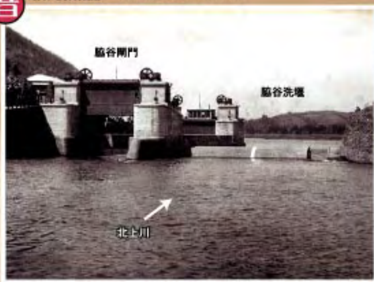
当時の土木技術の粋を集めて造られた脇谷洗堰・脇谷開門。 (脇谷洗堰・脇谷開門を左岸上流より望む)
