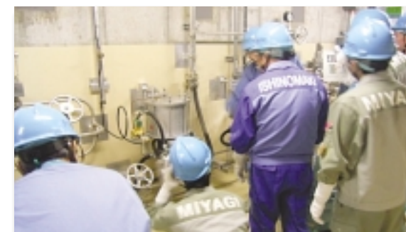
▲原子炉建屋内における現場確認
