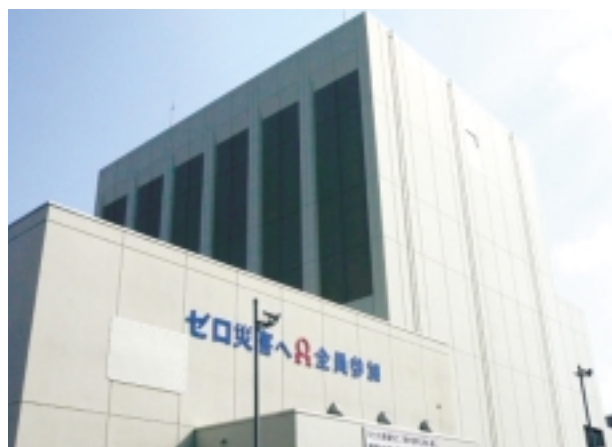
▲1号機原子炉建屋の外観
