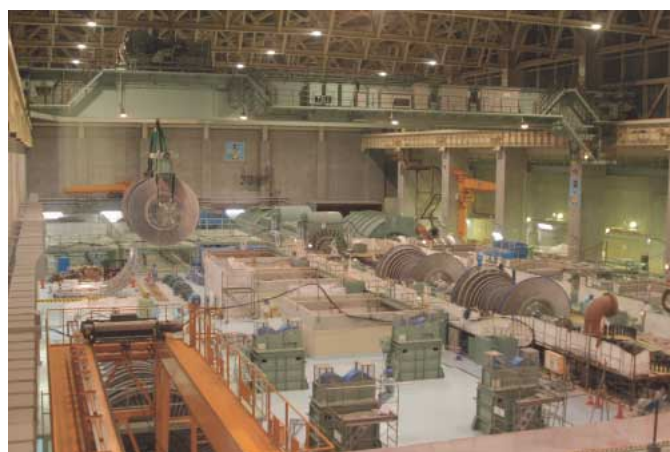
第1回定期検査での蒸気タービン設備点検の様子
