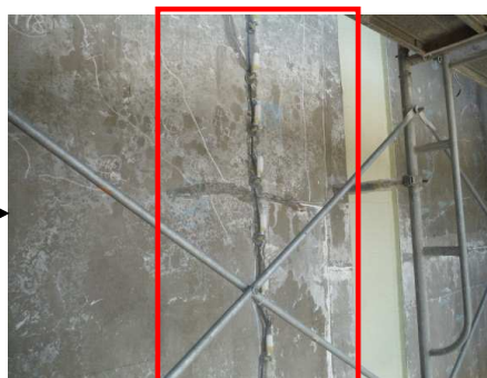
【エポキシ樹脂注入】
