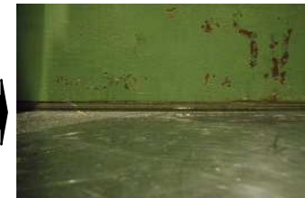
中間軸受箱 修繕後
