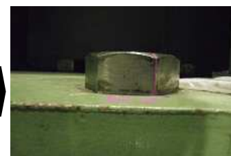
締付けボルト 取替後
