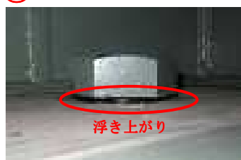
締付けボルト 取替前
