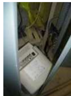
落下し破損したCRT
