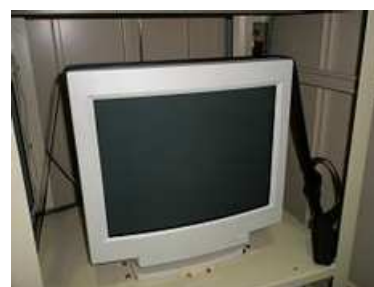
CRTの取替を実施
