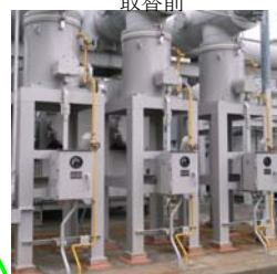
取替後(地震の揺れに強いタイプ)
