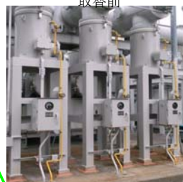
取替後(地震の揺れに強いタイプ)
