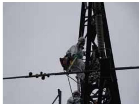
送電線への接地付け
