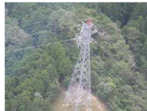
上空からの外部電源の状況 (送電線復旧作業個所)
