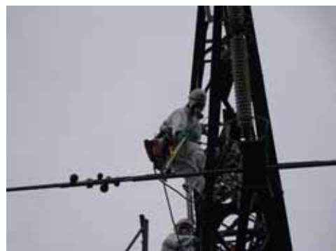
送電線への接地付け
