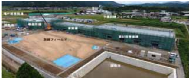
現地工事進捗状況(2016年9月27日)
