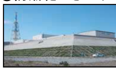
防潮堤の工事状況
