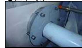
貫通部シール施工例
