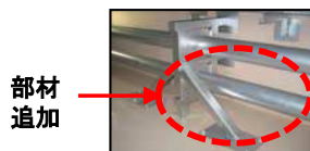
補強工事の例
