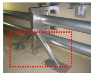
施工例(サポートの強化)
