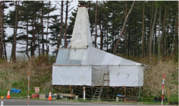
ボーリング調査状況（例）
