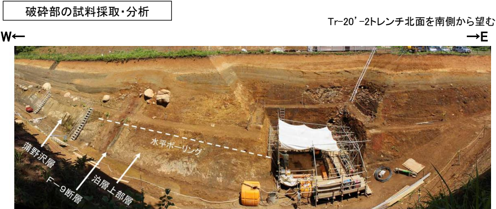
破砕部の試料採取・分析状況（水平ボーリング（Tr-20'-2トレンチ））
