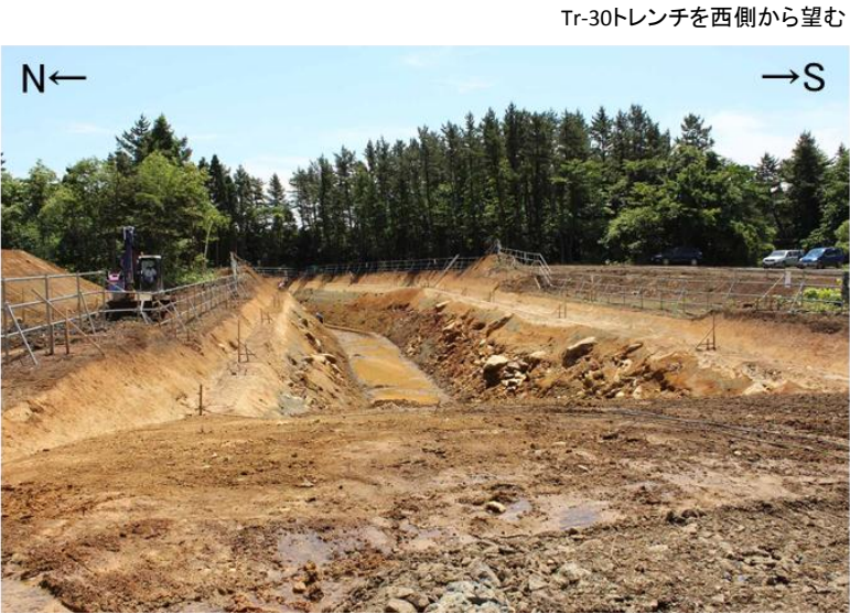
掘削状況（Tr-30トレンチ）
