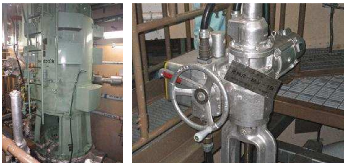
図 7-6 RHR ポンプおよび RHR 電動弁
