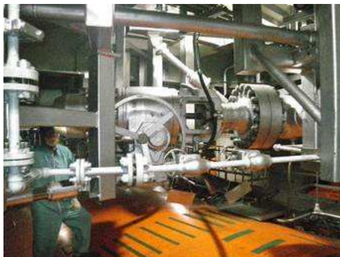
図 7-7 格納容器 トーラス上 — 耐震サポート
