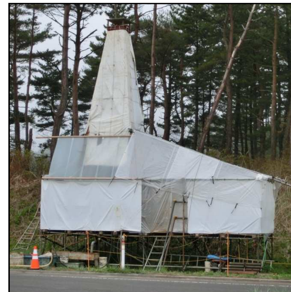
【ボーリング調査】
