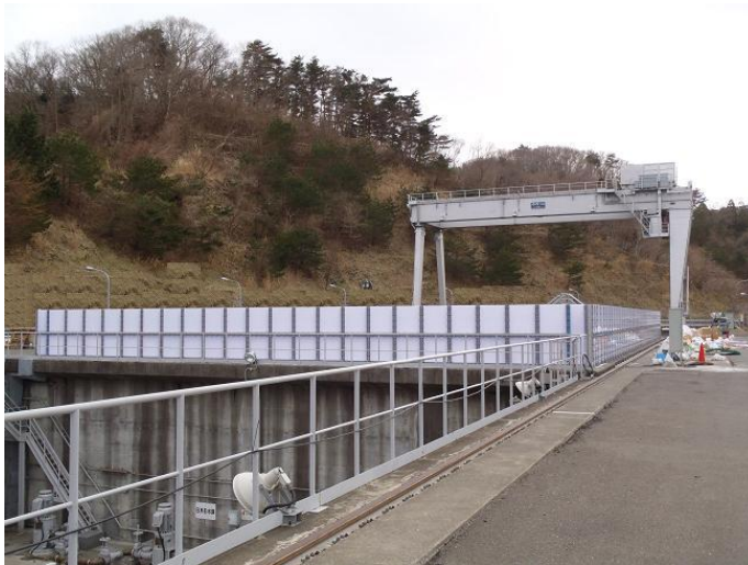
1号機海水ポンプ室 防潮壁
