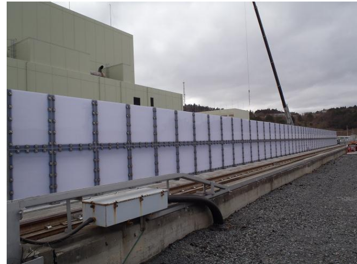
2号機海水ポンプ室 防潮壁
