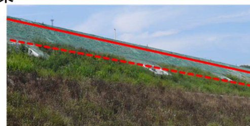
防潮堤高さ約3m(海拔約17m)
