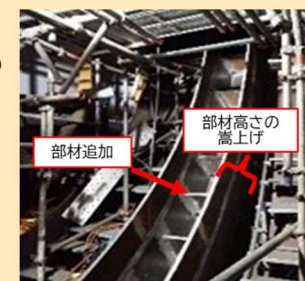
耐震工事イメージ
