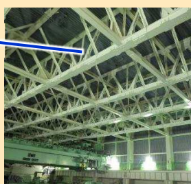
屋根トラス耐震補強工事
