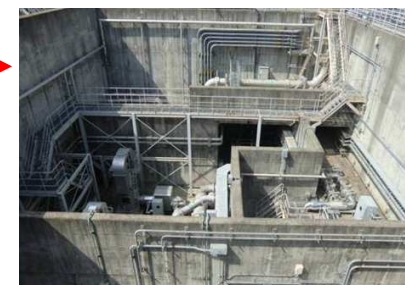
海水ポンプなどが設置されている立坑(ピット)
