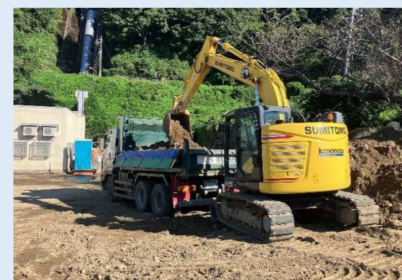
発電所構外への土砂搬出
