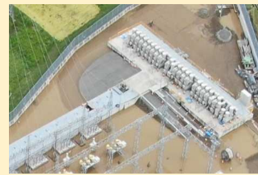
機器浸水回避に向けた変電所基礎の嵩上げ
