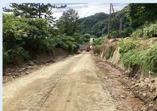
発電所搬入路の仮復旧
