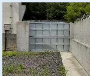
(防水扉を設置)
