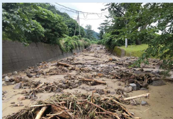
発電所搬入路への土砂流入
