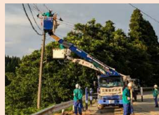
切れた電線の接続作業
