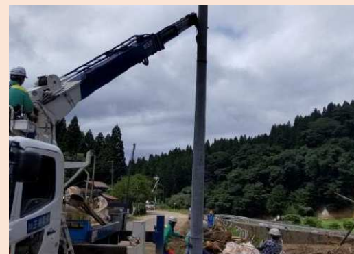
土砂崩れで流された電柱を 新たに建てる様子
