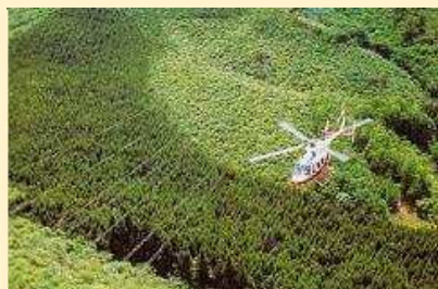
送電線のヘリ巡視
