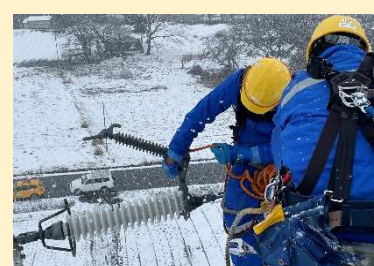
架空送電線への耐雷対策
