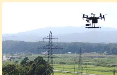
ドローンを活用した送配電設備の点検
