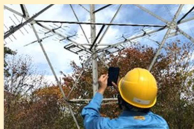
AIを活用した鉄塔塗装の点検
