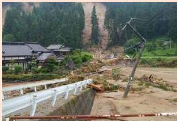
土砂崩れによる 電柱の折損・電線の断線
