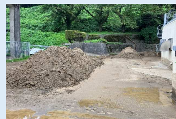
発電所構外への土砂搬出に向けた準備の状況
