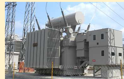
耐震性を向上したダイレクトモールド型変圧器ブッシングの採用
