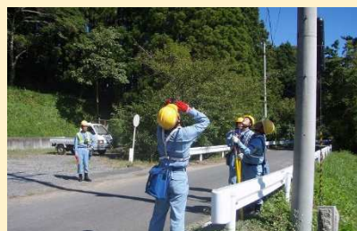
配電線の設備巡視
