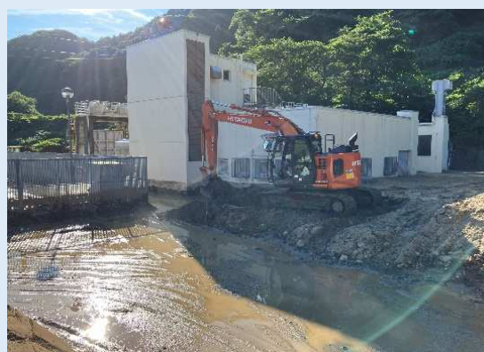
発電所構内の土砂排出
