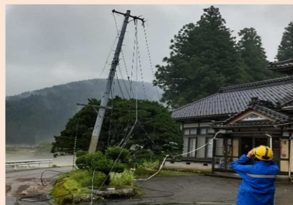
河川氾濫および土砂流出による 電柱の傾斜
