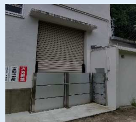
(止水板を設置)
