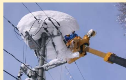
電柱からの冠雪落とし作業
