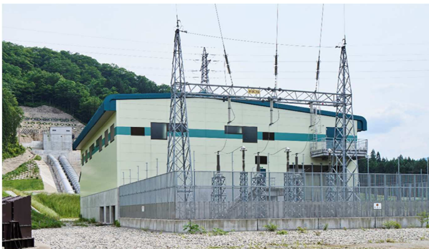
<玉川第二発電所>
