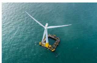
BW Idealの コンクリート製バージ型浮体 (写真提供：BW Ideal)
