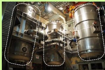
※ 原子炉圧力容器や原子炉格納容器の損傷防止、放射性物質の放出による環境影響を抑えるための装置。万一の際の放射性物質の放出量を直接放出時に比べ1,000分の1以下に抑制する。
