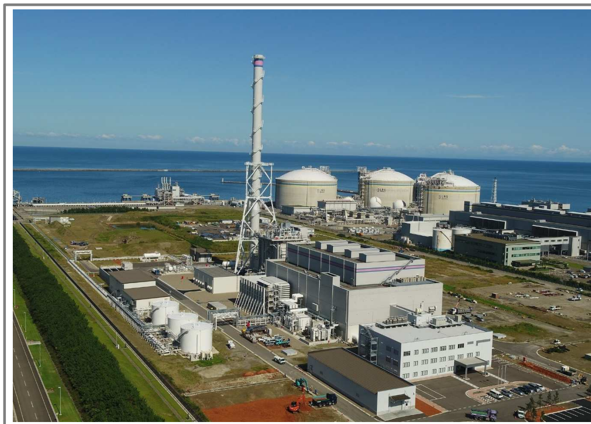
上越火力発電所の全景
