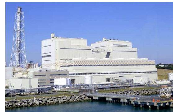
原町火力発電所
