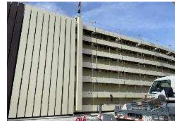
防潮堤かさ上げ工事
