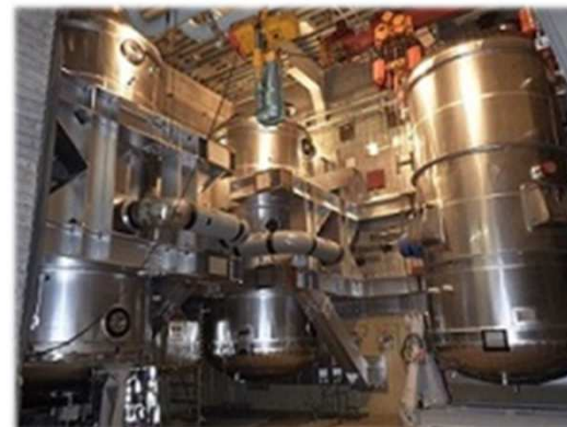
フィルタベント系設置工事
