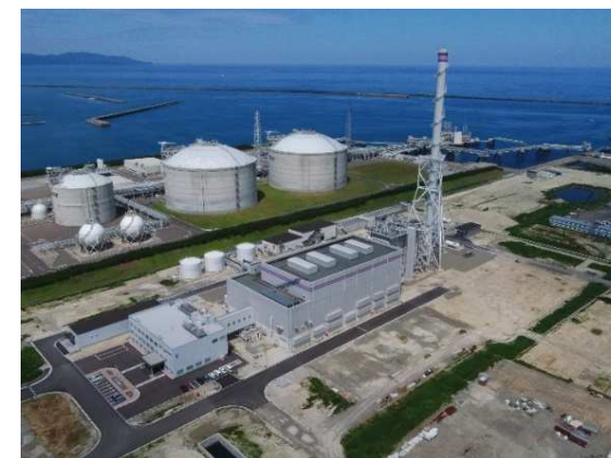
上越火力発電所
