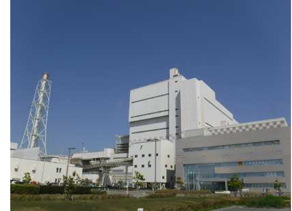
原町火力発電所
