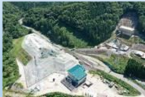
玉川第二発電所 開発現場 (山形県小国町)
