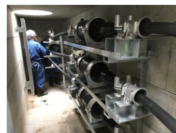
電力ケーブル接続工事
