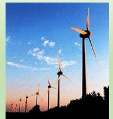
能代風力発電所 (秋田県能代市)
