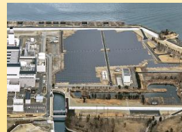
仙台太陽光発電所 (宮城県七ヶ浜町)
