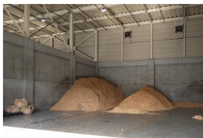
バイオマス保管倉庫内 (原町火力発電所)
