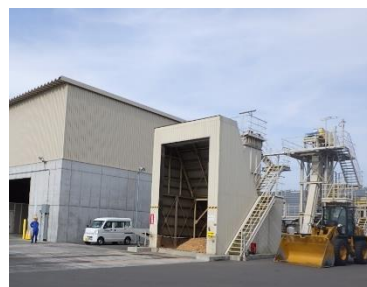
バイオマス受入設備 (原町火力発電所)
