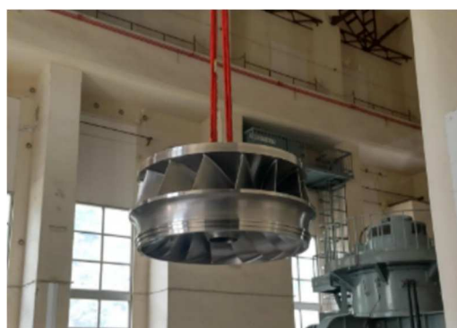
水車吊り込みの様子（3号機）
