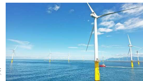
能代港洋上風力発電所 (提供: 秋田洋上風力発電株式会社)
