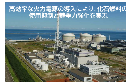
上越火力発電所1号機
