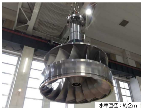
水車吊り込み状況
