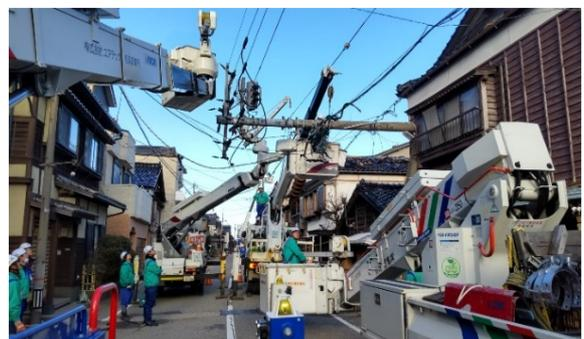
折損した電柱の改修
