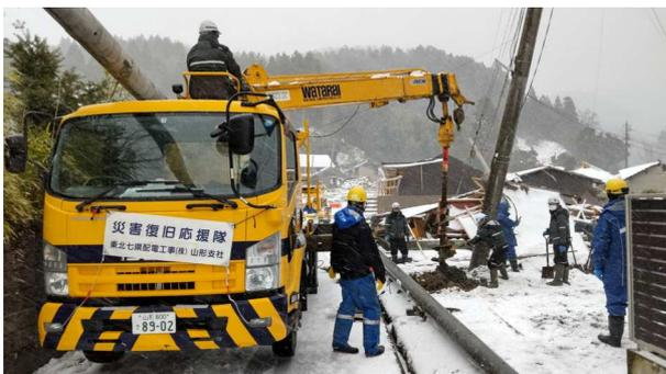
傾斜した電柱の改修
