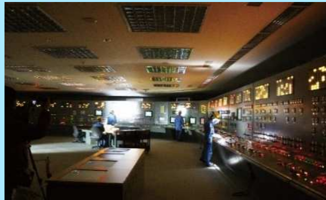
全交流電源喪失を想定した運転訓練 （運転シミュレータ訓練施設）
