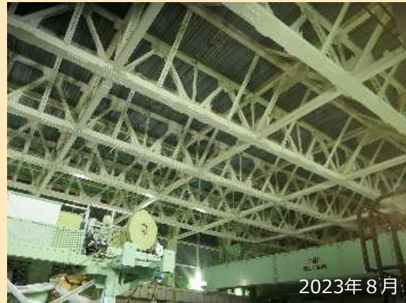
【耐震補強工事（原子炉建屋上部）】
