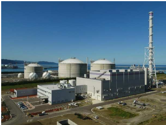
建設状況 (2022年9月時点)
