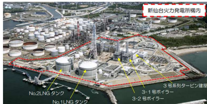
新仙台火力発電所3号系列
