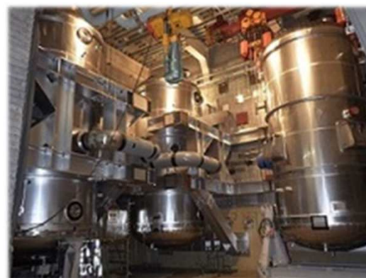
フィルタベント系設置工事
