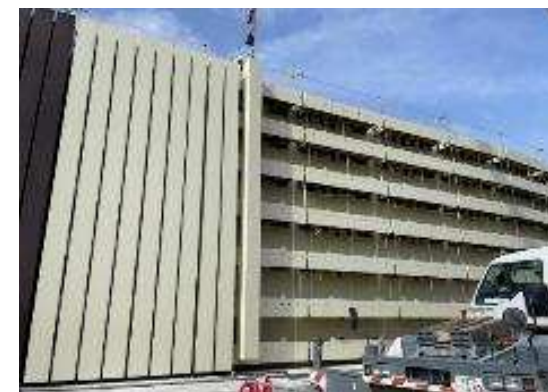
防潮堤かさ上げ工事
