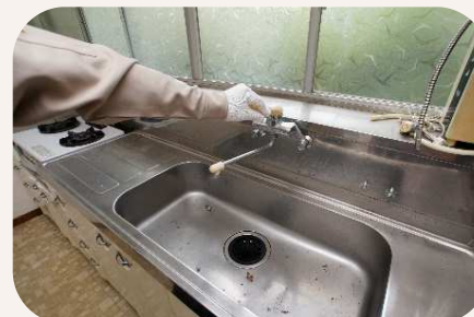
水回りの破損の目視確認や通水
