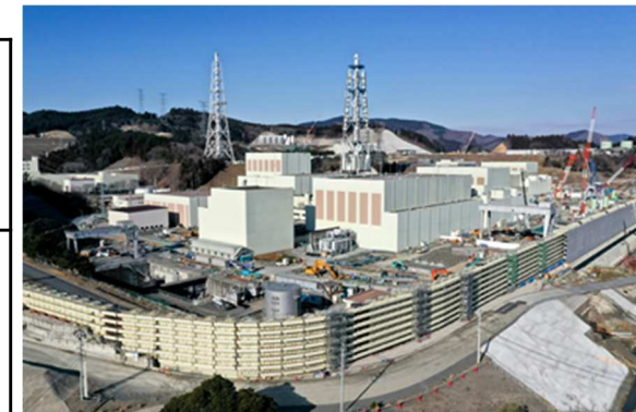
工事が進む女川原子力発電所の防潮堤
