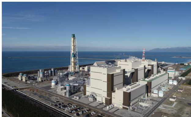
能代火力発電所
