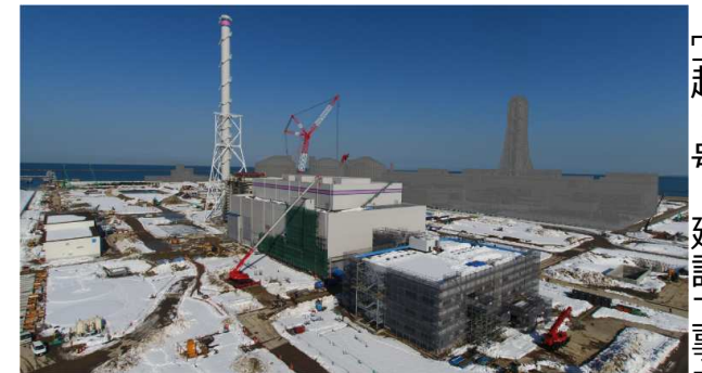
上越1号・建設工事中
