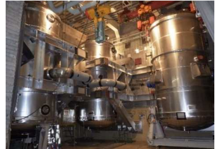
安全対策工事が進む女川2号機 (フィルタ付格納容器ベント装置)
