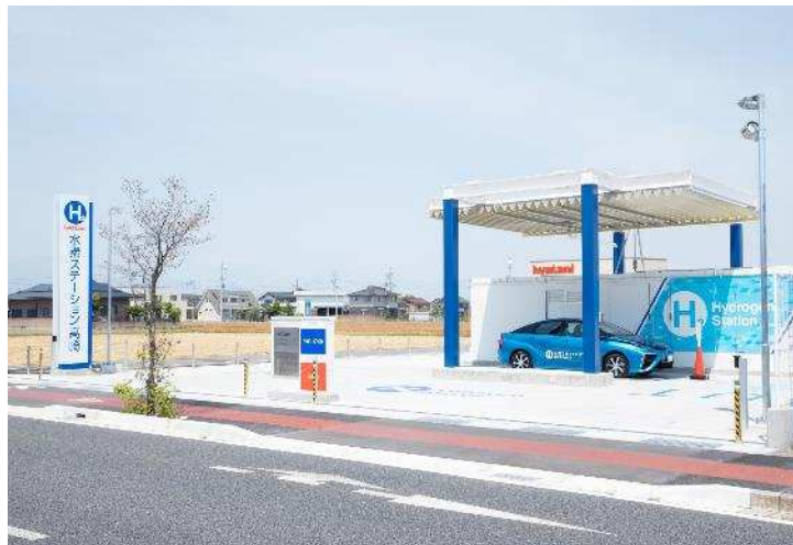
図2 FH2Rで製造した低炭素水素の充填を行った「イワタニ水素ステーション群馬高崎」 (写真提供: 岩谷産業(株))
