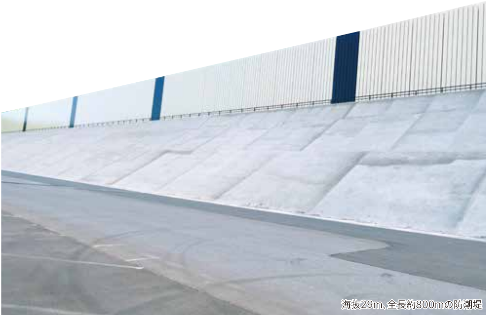
海拔29m、全長約800mの防潮堤
