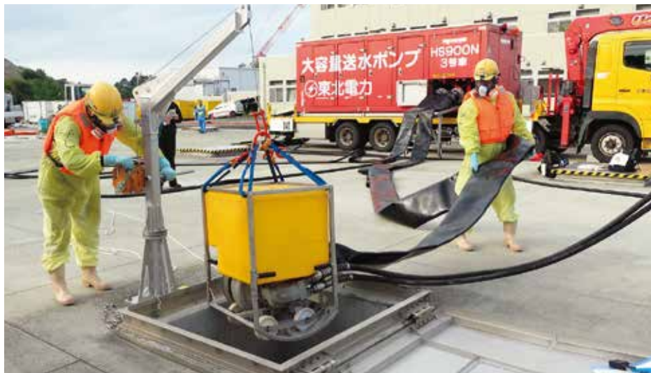
大容量送水ポンプ車を用いた注水訓練
