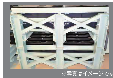
所内常設直流電源設備(蓄電池)
