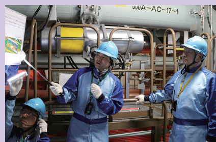
原子炉建屋を視察する様子
