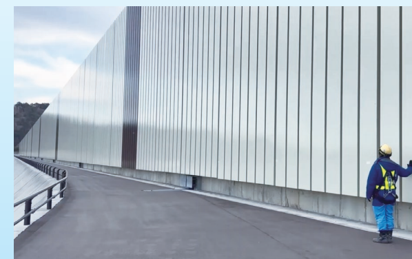
防潮堤を点検する発電所員
