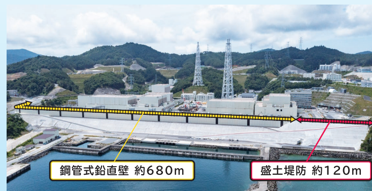
総延長約800mの防潮堤（全体像）
