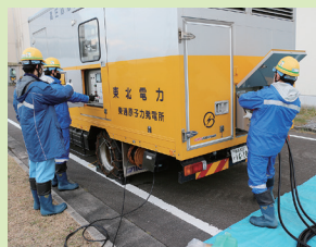
電源車接続訓練
