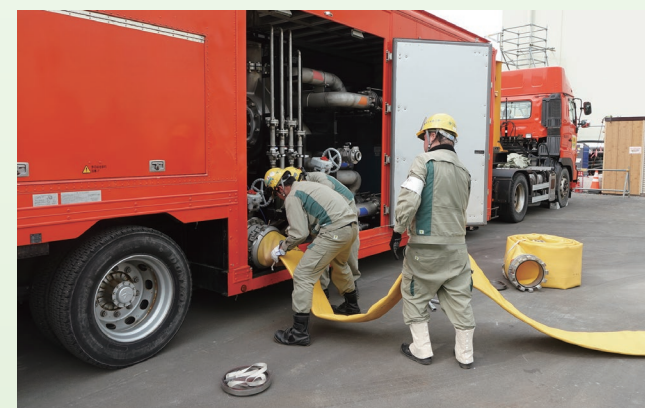
熱交換器ユニットへのホース接続
