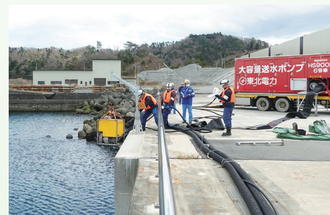
大容量送水ポンプ車を用いた海水の取水 （ポンプを海中に吊り下ろす作業）
