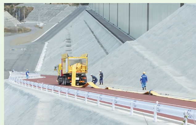
ホース延長回収車の荷台からホースを引き出し敷設 （防潮堤付近）
