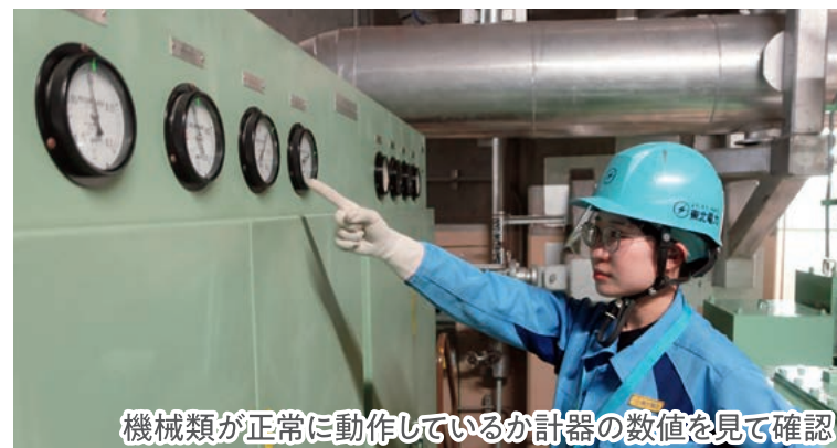
発電所建屋内外をくまなく巡視
