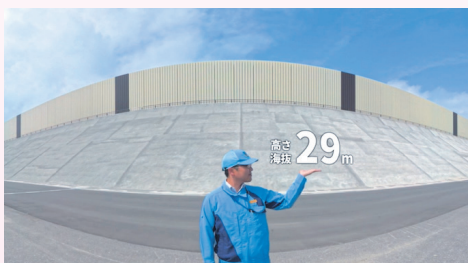
海拔29mの防潮堤
